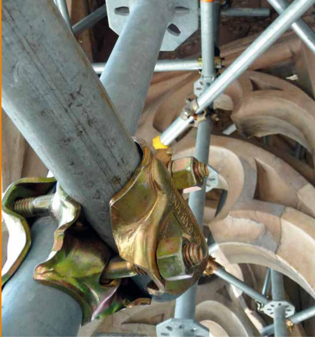
Il sistema giunto-tubo è l'ideale laddove siano richieste un'elevata resistenza associata ad una grande flessibilità d'impiego. Il tubo Marcegaglia ha caratteristiche tecniche che lo rendono idoneo agli impieghi più gravosi, mentre i giunti sono realizzati mediante stampaggi a freddo e protetti contro la corrosione mediante tropicalizzazione: il loro serraggio è assicurato da speciali bulloni con testa a T.
