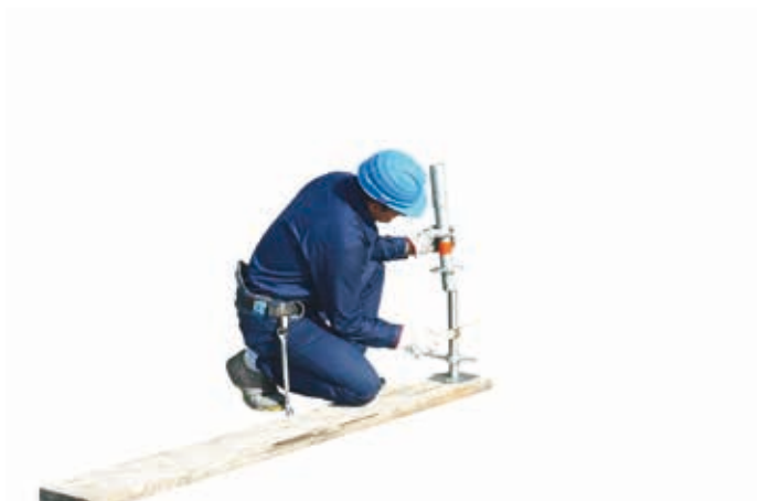
1 • posizionamento basette
