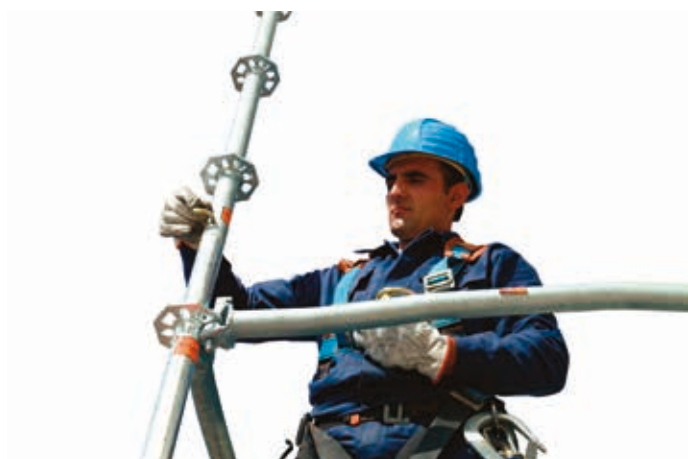
32 • inserimento spina di collegamento
