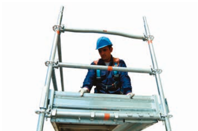
26 • montaggio fermapiedi di testata
