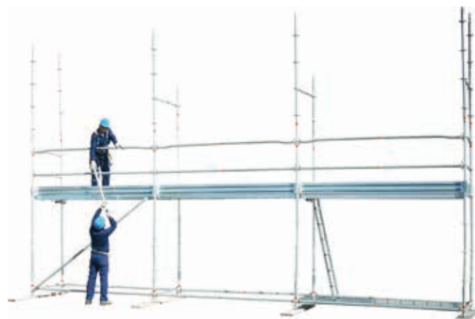
34 • montaggio traversi e parapetti 2° piano
