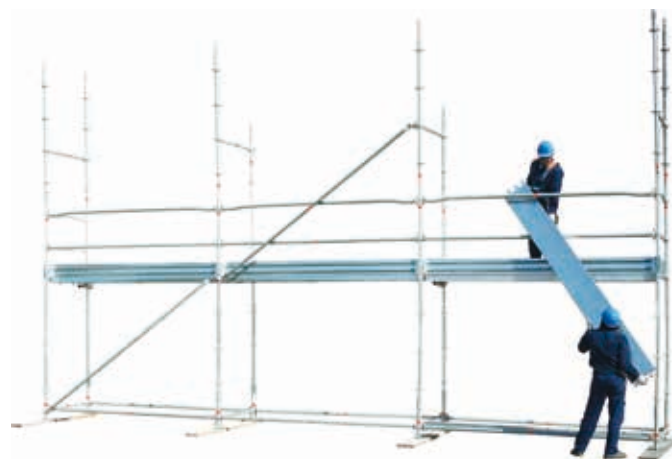
36 • montaggio impalcato 2° piano
