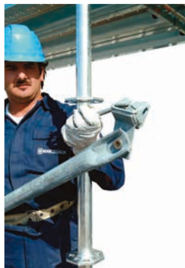
18 • montaggio diagonale
