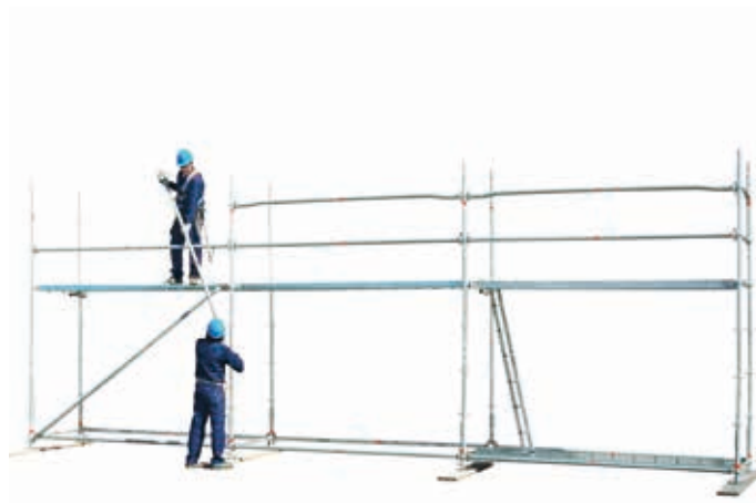
24 • montaggio parapetto 1° livello
