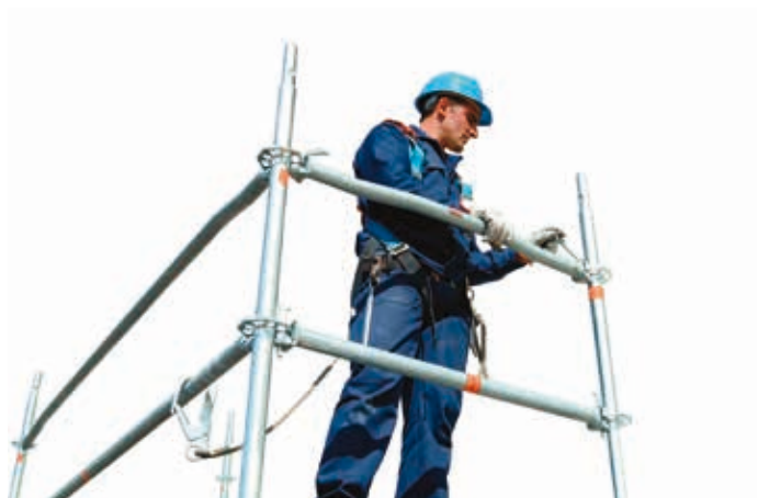
25 • montaggio parapetto di testata
