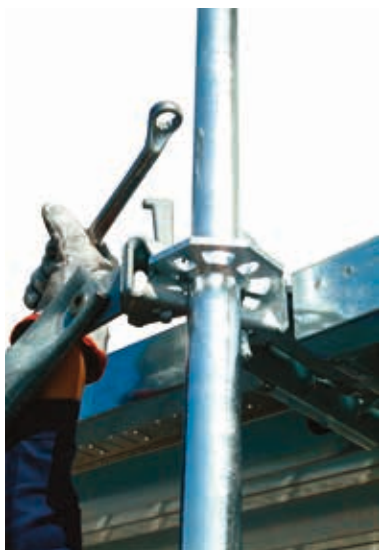
19 • montaggio diagonale
