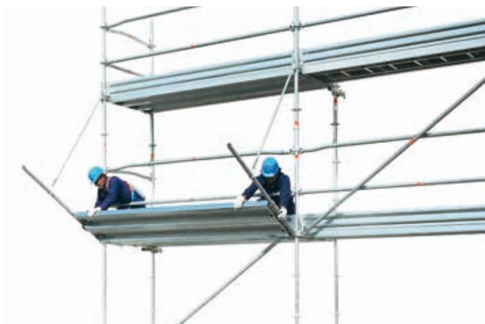
49 • montaggio tavole parasassi
