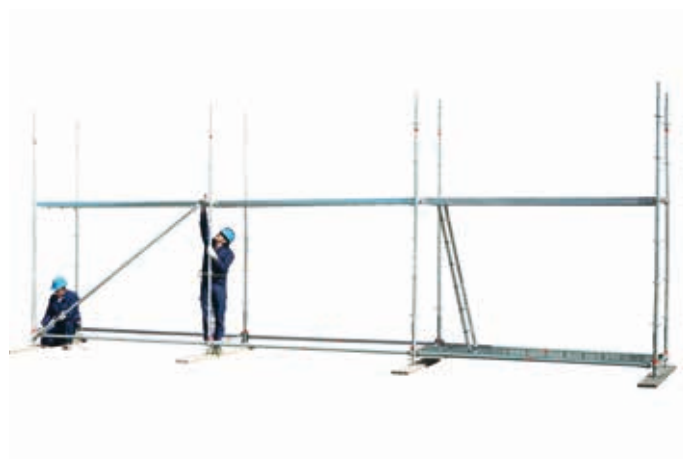
17 • montaggio diagonale
