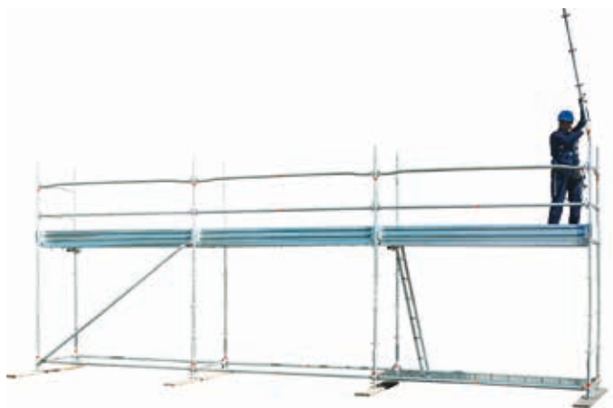
31 • montaggio montanti superiori
