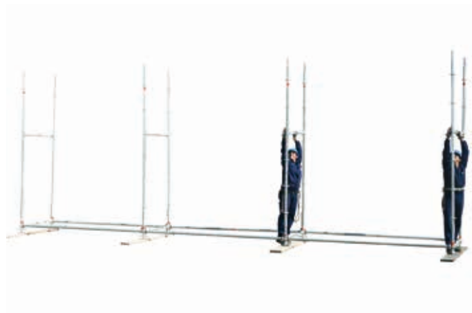
12 • montaggio traversi superiori
