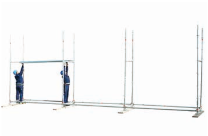
13 • montaggio tavole metalliche
