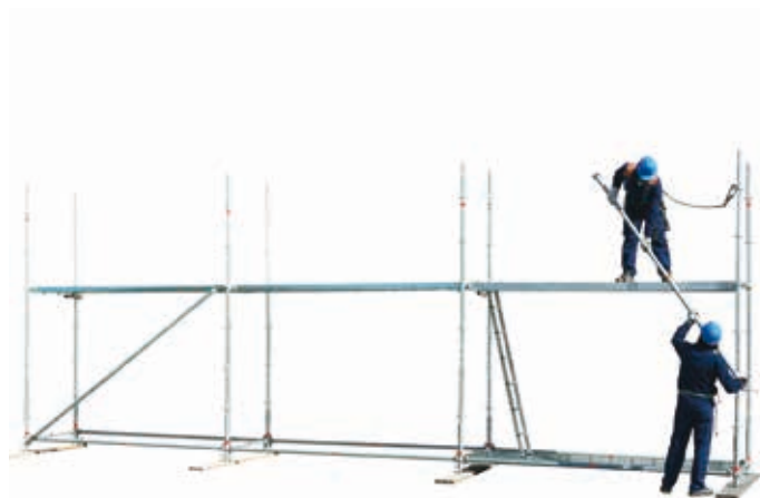
22 • montaggio parapetto 1° livello
