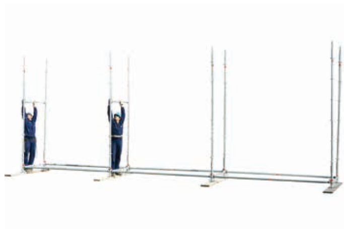
11 • montaggio traversi superiori
