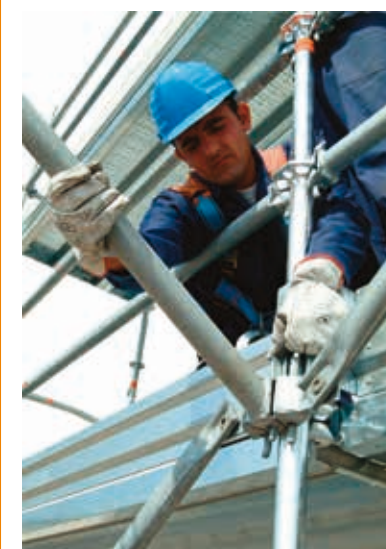
48 • montaggio parasassi
