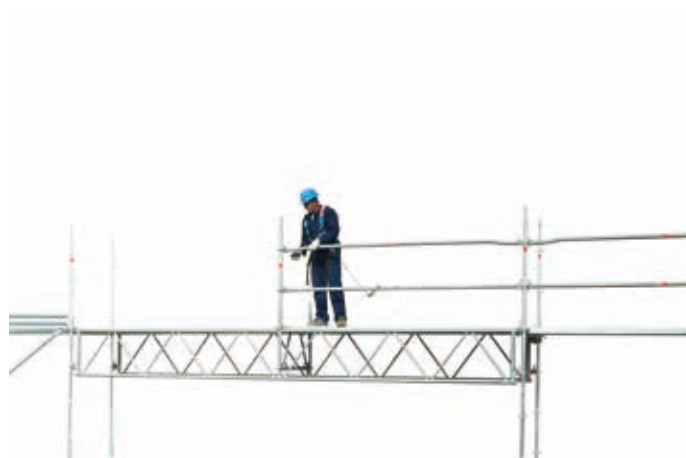
52 • montaggio parapetto trave carraia
