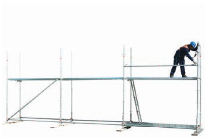
23 • montaggio parapetto 1° livello
