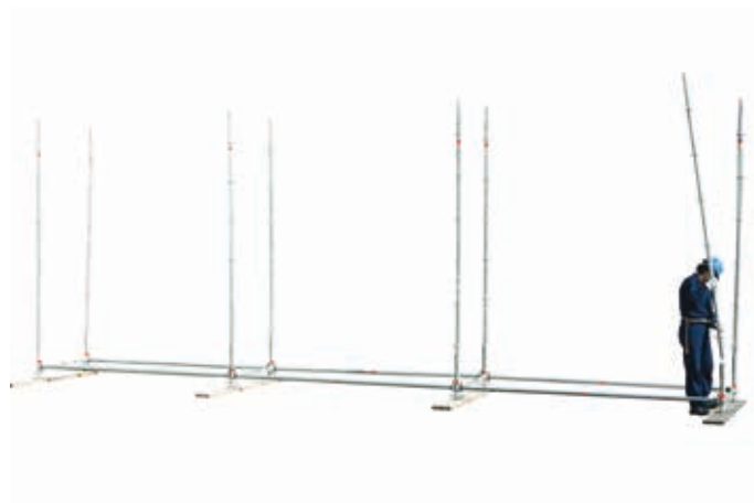
10 • montaggio montanti
