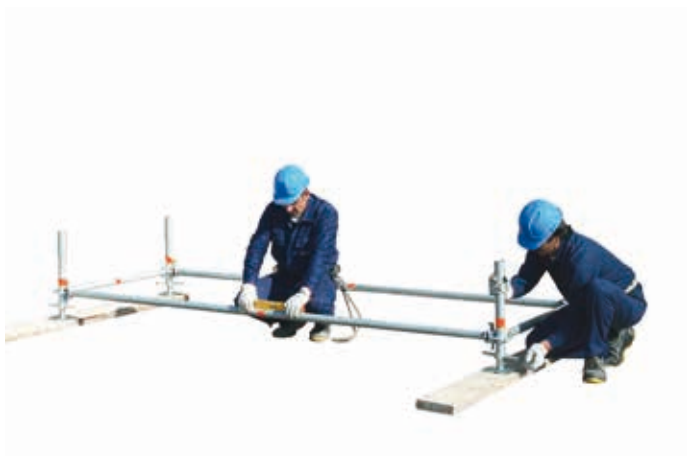
7 • livellamento longitudinale
