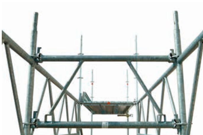
51 • montaż połączenia wiązaru przejazdowego
