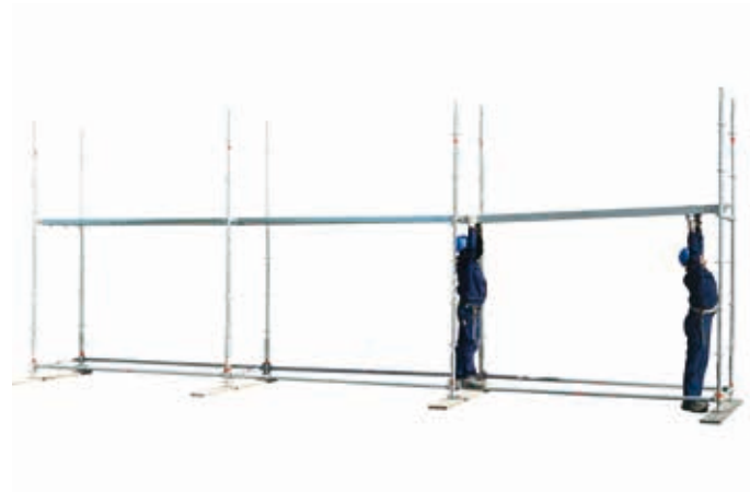
16 • montaż płyty podestowej z wiałem
