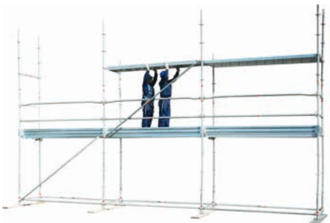
38 • montaż płyty podestowej z włazem
