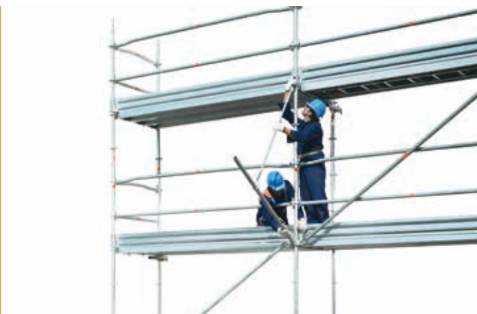
46 • montaż osłony odpryskowej
