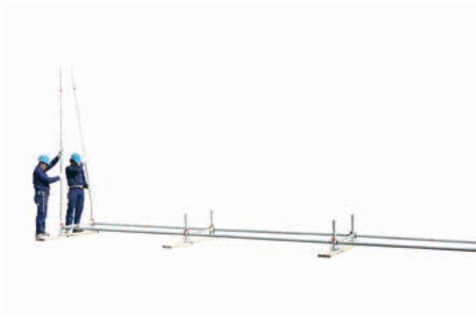
9 • montaż słupków
