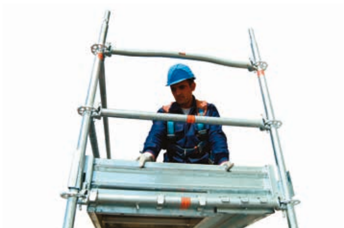
26 • montaż bortnicy czołowej
