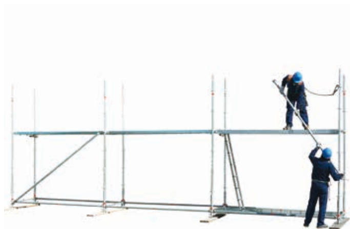
22 • montaż poręczy na 1 poziomie
