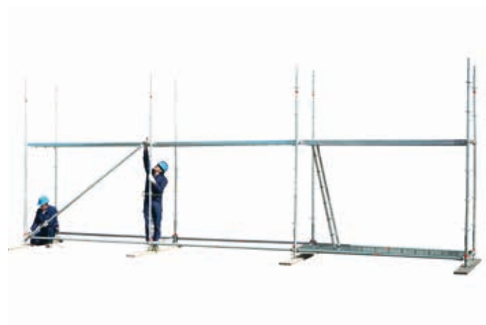
17 • montaż stężeń poprzecznych
