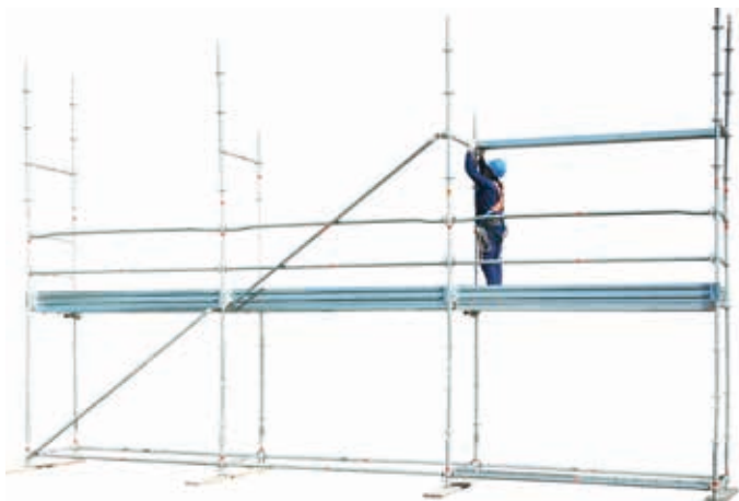
37 • montaż podestu na 2 poziomie
