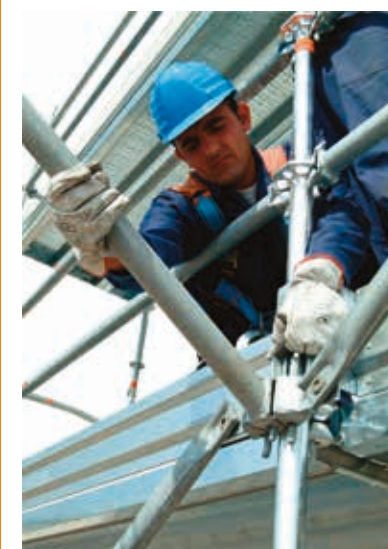
48 • montaż osłony odpryskowej
