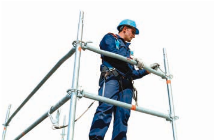
25 • montaż poręczy czołowej
