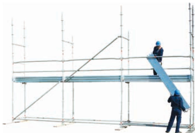
36 • montaż podestu na 2 poziomie
