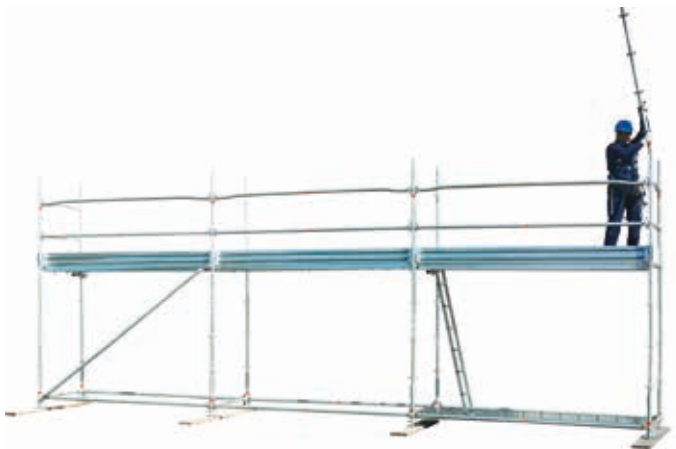
31 • montaż słupków górnych
