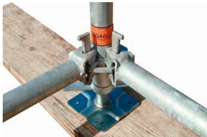
4 • montaż stężeń wzdłużnych
