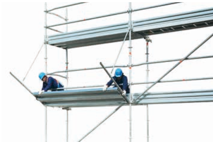
49 • montaż płyt osłony odpryskowej
