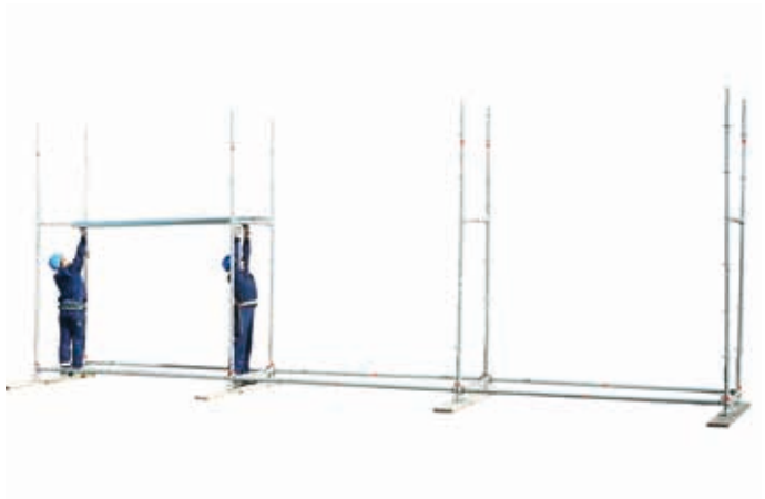
13 • montaż metalowych płyt podestowych
