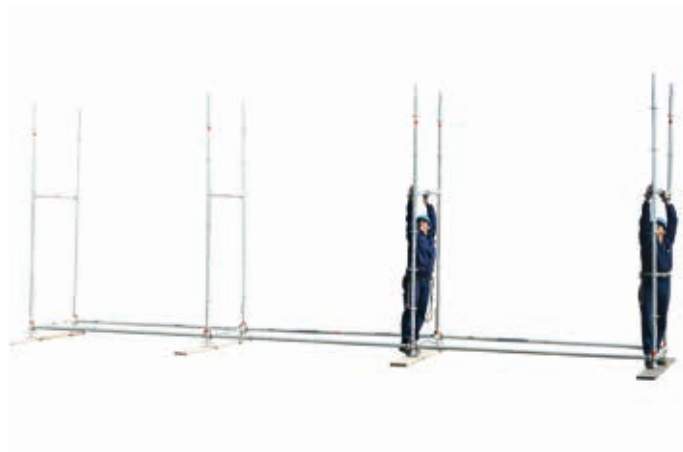
12 • montaż poprzeczek górnych
