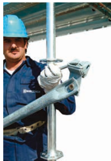
18 • montaż stężeń poprzecznych
