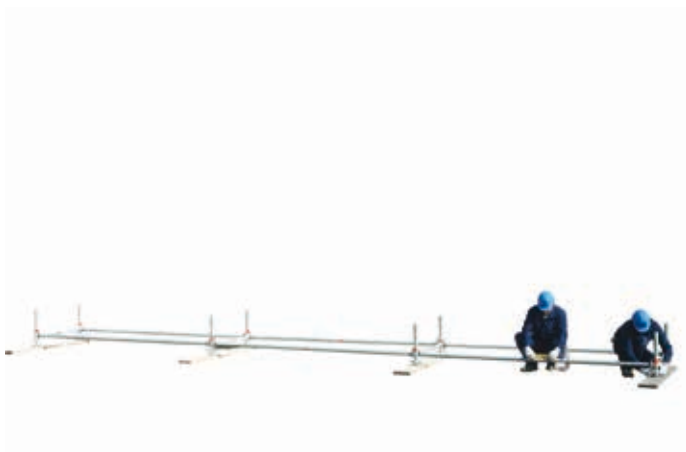
8 • końcowa kontrola poziomowania
