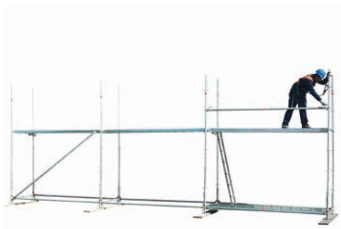
23 • montaż poręczy na 1 poziomie
