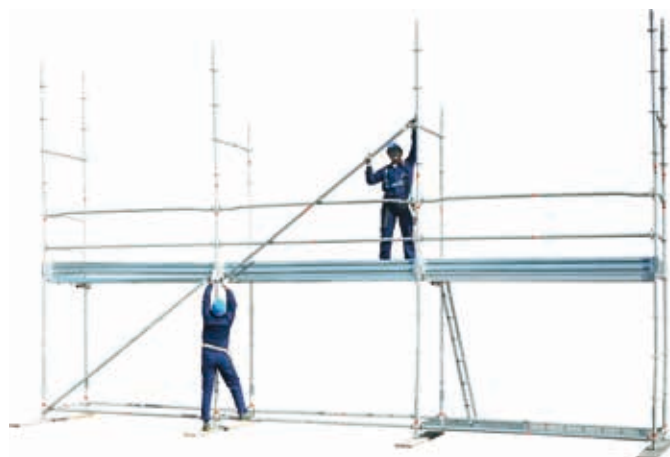
35 • montaż stężeń poprzecznych co 4 przęsła na poziom
