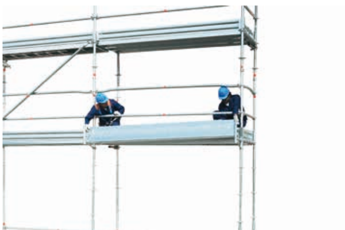
44 • montaż płyty uchylnej
