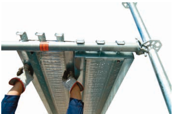
14 • montaż metalowych płyt podestowych
