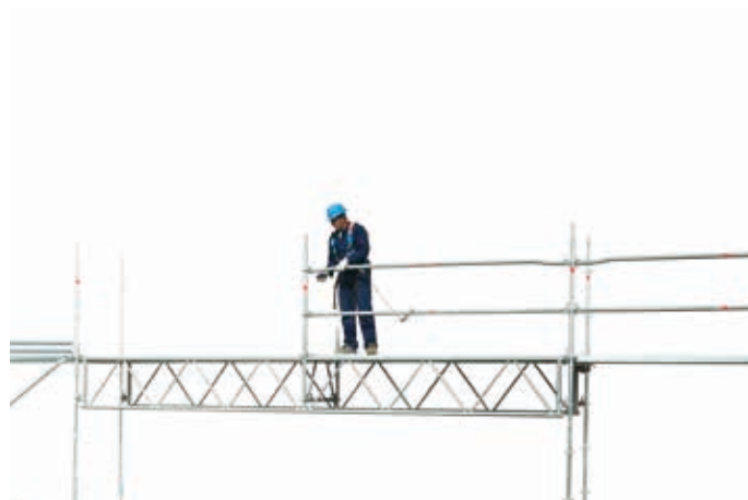
52 • montaż poręczy wiązara przejazdowego
