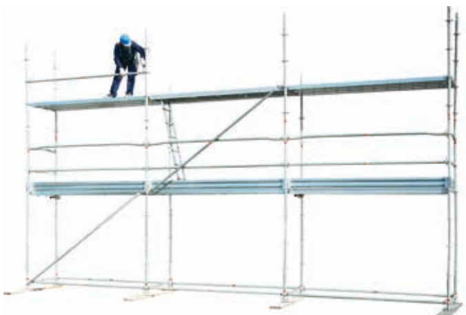
39 • montaż poręczy na 2 poziomie
