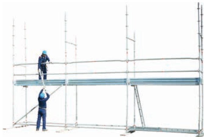
34 • montaż poprzeczek i poręczy na 2 poziomie
