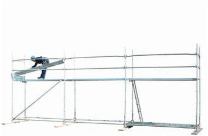
27 • montaż bortnicy czołowej
