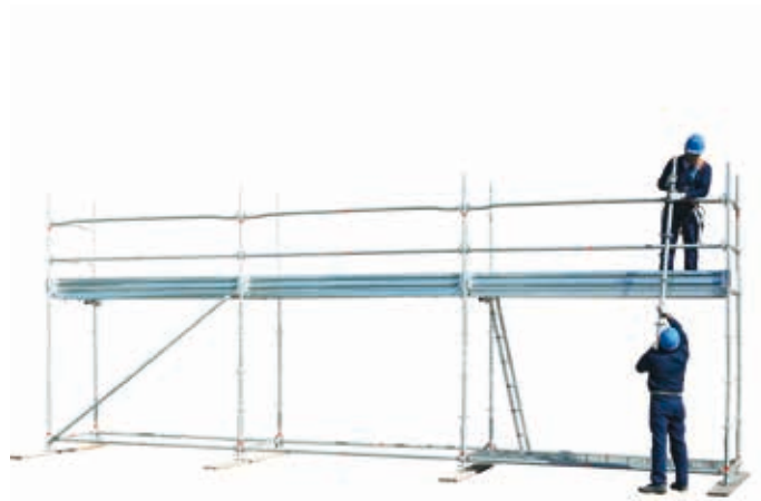
30 • montaż słupków górnych
