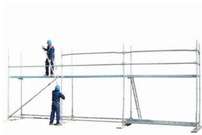
24 • montaż poręczy na 1 poziomie
