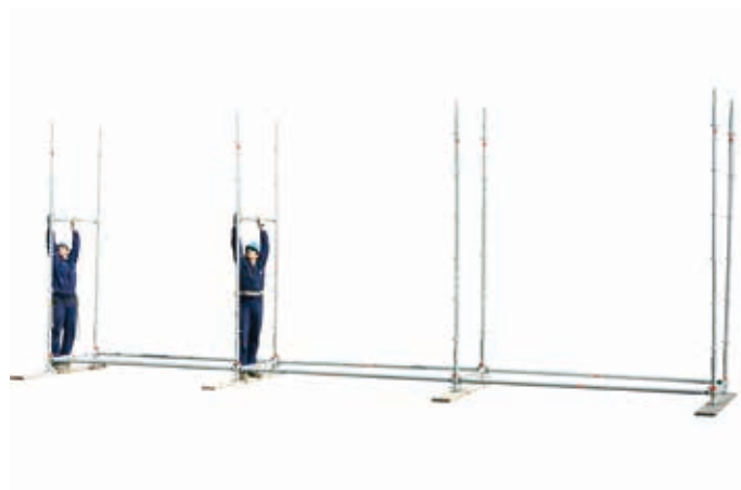
11 • montaż poprzeczek górnych
