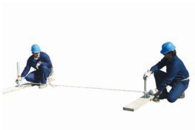
5 • ustawienie kolejnej sekcji
