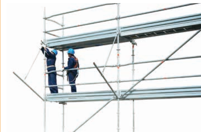
47 • montaż osłony odpryskowej
