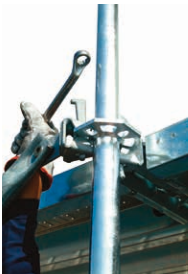
19 • montaż stężeń poprzecznych
